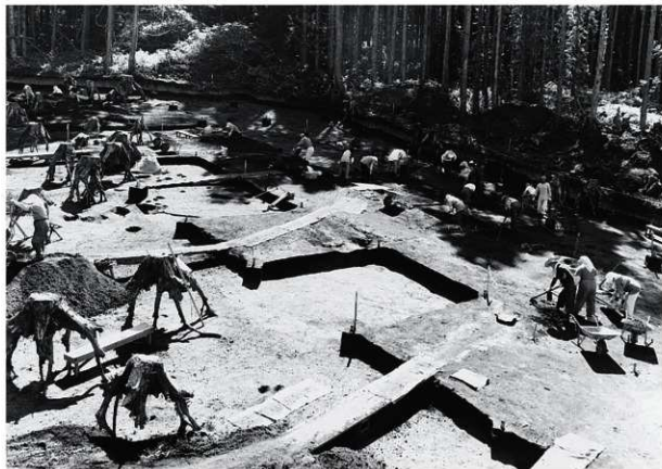
2 C地区調査風景 (北から)
