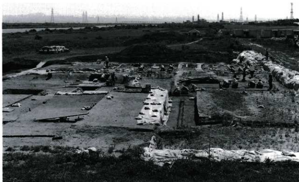
調査風景（149ラインより東）W→E
