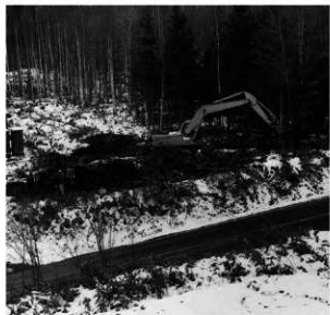
3 平成8年度低位部表土除去(北東から)
