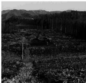
4 平成 7年度低位部表土除去(西から)
