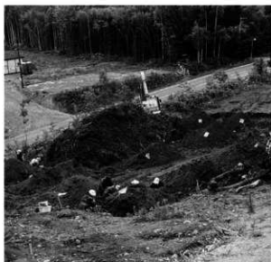
2 平成 8年度斜面部調査(北西から)
