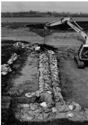
壁面保護用大型土嚢撤去作業 SW→NE
