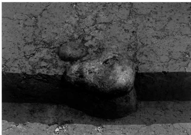
S-21検出状況 SW→NE
