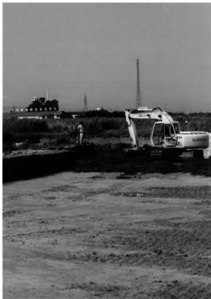
重機による確認調査 E→W
