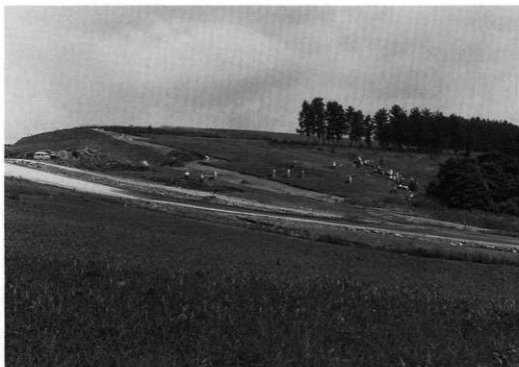
図版2 発掘調査前の状況
