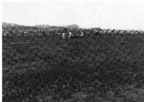
工事立会風景
