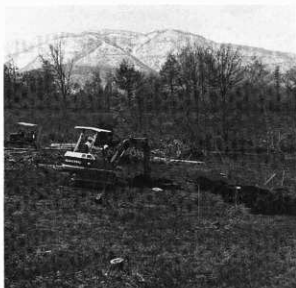
工事立会風景
