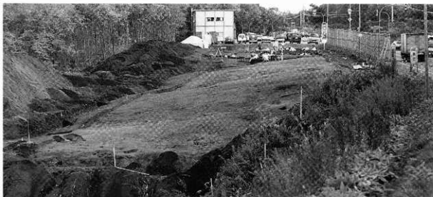
2. 調査区西側完掘状況
