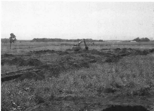
1. 重機作業風景
