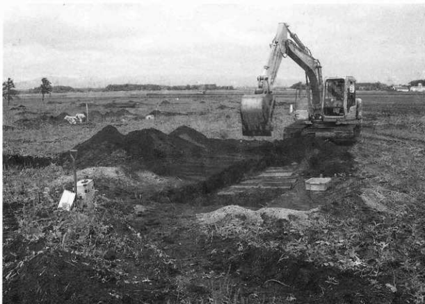
2. 重機作業風景
