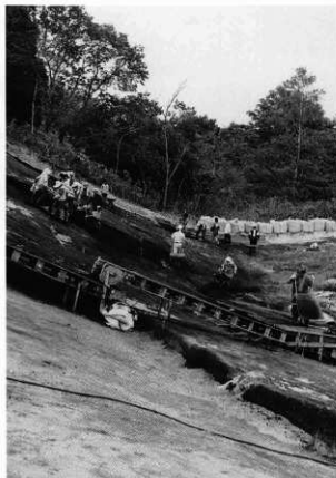
ベルコン使用作業状況
