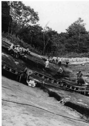
バルコン使用作業状況
