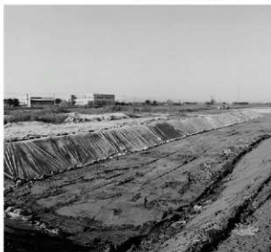
越冬養生状況 E→W
