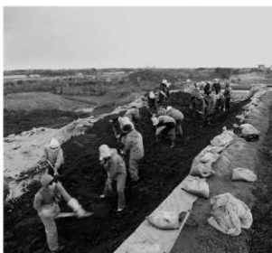
越冬養生作業風景 W→E
