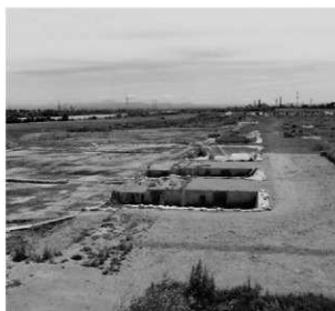
トレンチ調査風景 W→E
