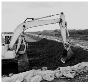
重機による法面施工状況 NW→SE
