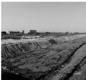
越冬養生状況 E→W
