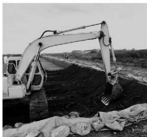
重機による法面施工状況 NW→SE
