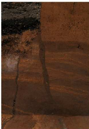
噴砂と断層 (73-151-エ) NE→SW
