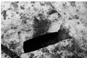
H-3 HP-3 セクション (南西から)
