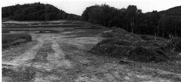
10 埋め戻し作業終了（北東から）
