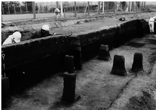
1 PH-1~6 全景(北西から)
