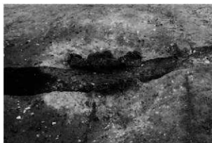
VF-2 土层断面
