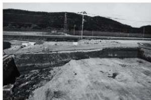
1 東側メインセクション (西から)
