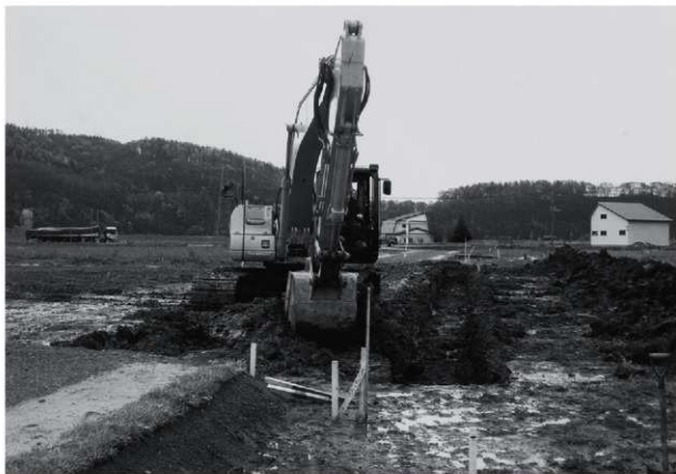
1 平成20年度 学田三区3遺跡工事立会（西から）
