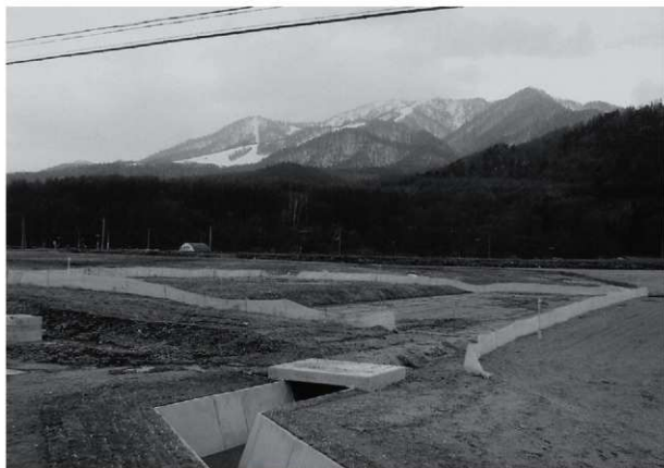
1 学田三区 2 遺跡の調査前（北から）
