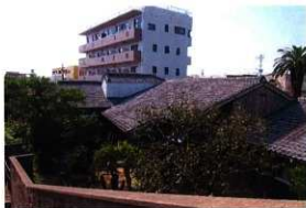
写真 1 遠藤家住宅を南西側からみる
