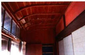
写真 3 玄関横縁側を見上げる
