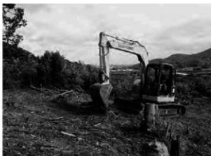
写真1 バックホウによる表土除去作業
