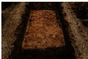
試掘坑9 完掘状況
