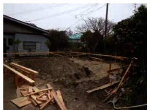
調査対象地近景
