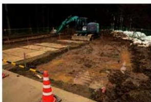
調査対象地 近景（南→）
