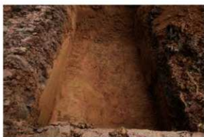
試掘坑5 完掘状況
