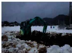
調査対象地近景
