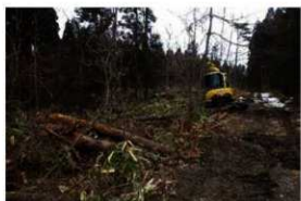
調査地点2（鉄塔No.15）近景
