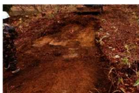
調査地点 3 試掘坑 2 調査状況
