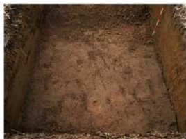
試掘坑5 完掘状況
