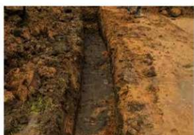
調査地点 2 試掘トレンチ 1 完掘状況
