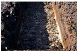
試掘坑16 完掘状況
