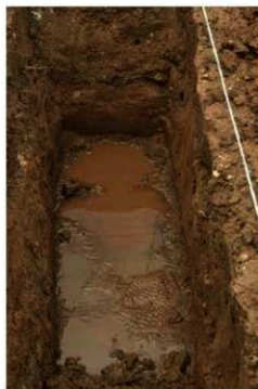
試掘坑 1 完掘状況
