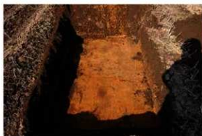
試掘坑 1 完掘状況
