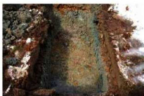
試掘坑 5 完掘状況
