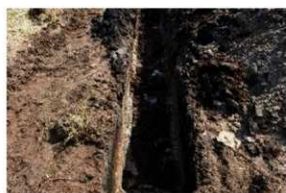
調査地点 5 試掘トレンチ 1 完掘状況
