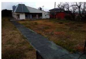
調査対象地近景
