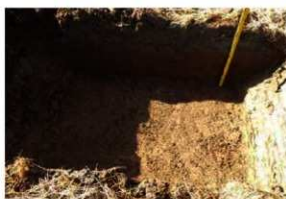
試掘坑 2 完掘状況
