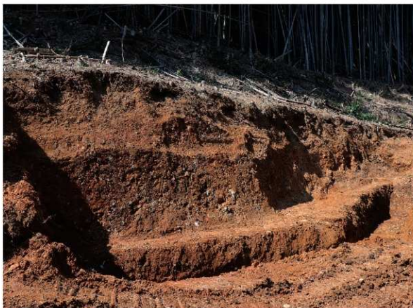
A・B地点 断面（南東から）
