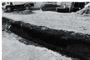
図22 B-B' 間東西溝 (北から)
