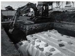
図11 25次 埋め戻し風景 (北東から)
