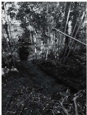
図2 24次 重機掘削風景（南西から）
