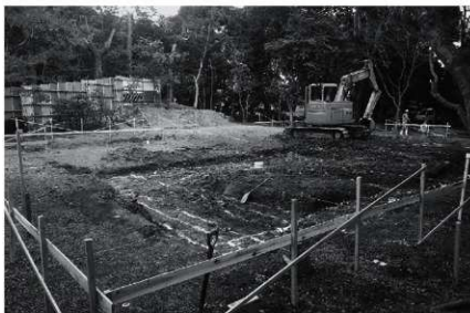
図18 第1トレンチ該当部遠景（南西から・平成26年（2014）1月16日）
