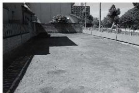
図6 埋戻し終了状況(南から)
