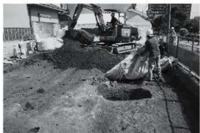
図5 埋戻し状況(南から)
