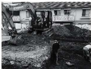
図7 25次 重機掘削風景（東から）
