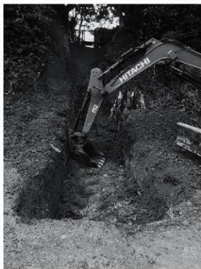
図3 24次 埋め戻し風景（北から）
