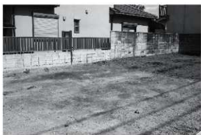
図3 調査前全景(南東から)
