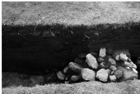
二ノ丸虎口石積 2 及びBセクション (北から)
