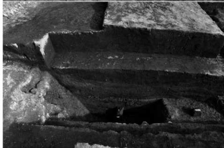
清水曲輪空堀セクション 及び整地層
