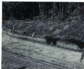
東側土層断面
