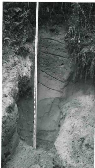
3トレンチ調査状況
