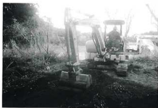
4トレンチ調査状況
