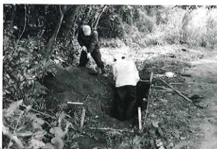
4トレンチ調査状況
