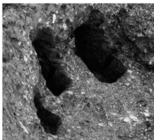
KP-14西側逆杭セクション SE→NW
