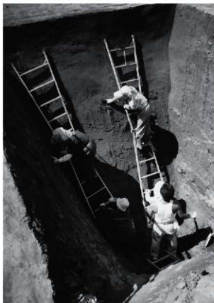
大深度試掘坑壁面清掃作業 NE→SW
