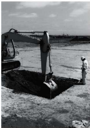
大深度試掘坑調査 W→E
