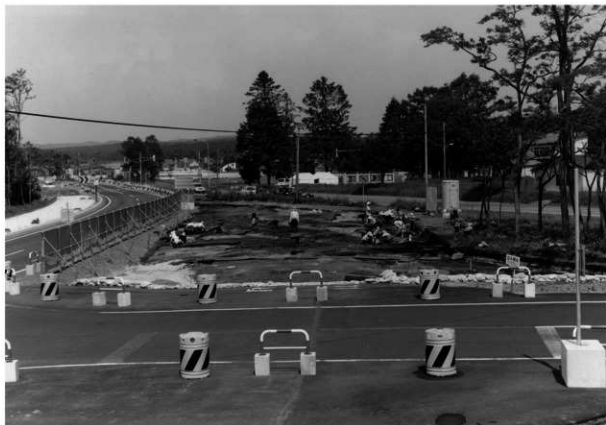
調査区南東側 作業状況 (W→)
