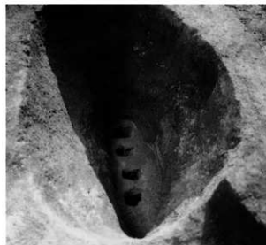
TP-10 杭 確認 (NE→)
