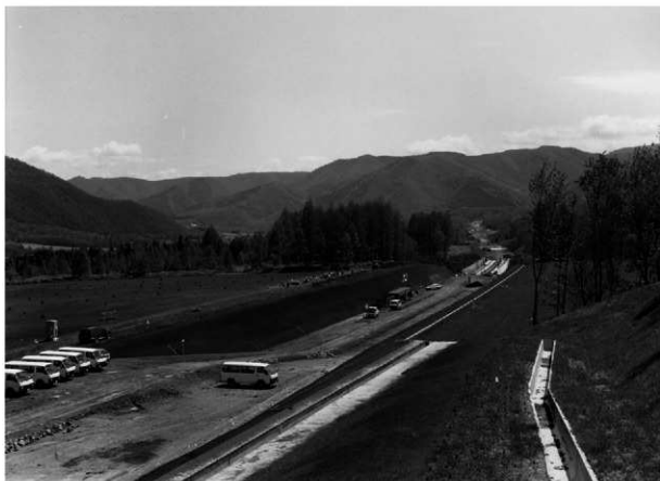
1 包含層調査(南西から)
