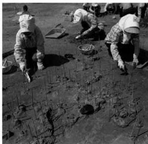
2 L10区(南東から)
