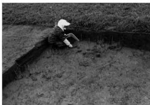
4 N8区(北西から)
