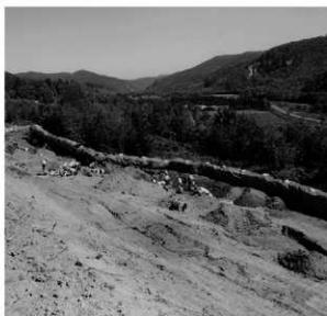
5 重機+人力調査(斜面部、南西から)
