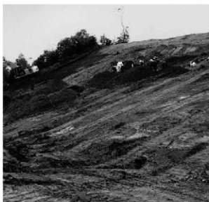
4 重機+人力調査(斜面部、北東から)
