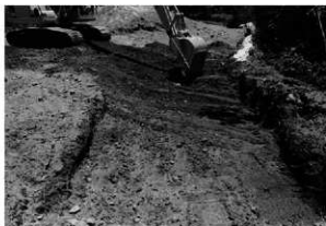
4 重機調査(中位部、南西から)
