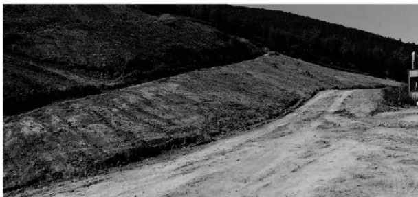
3 斜面部調査終了(南から)
