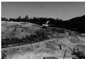
1 重機調査(斜面部、南東から)
