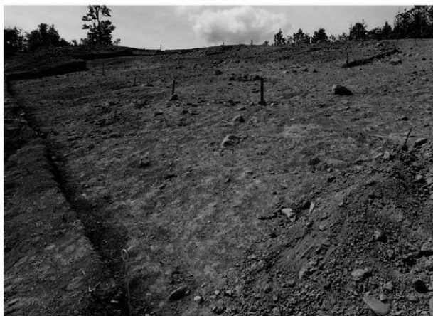
2 高位部調査終了(東から)
