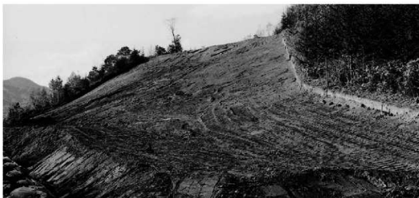
1 斜面部調査終了(北東から)
