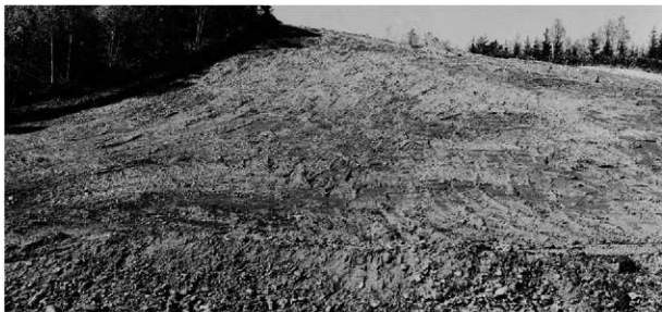
2 斜面部調査終了(南東から)
