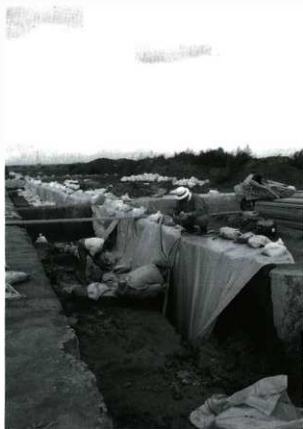
降雨後排水作業風景 SE → NW
