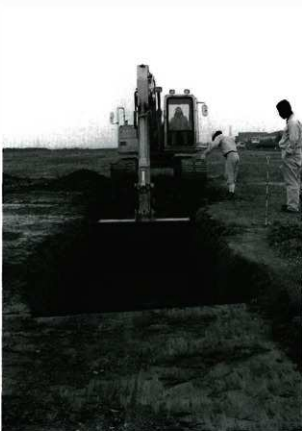
トレンチ調査開始状況 NW → SE
