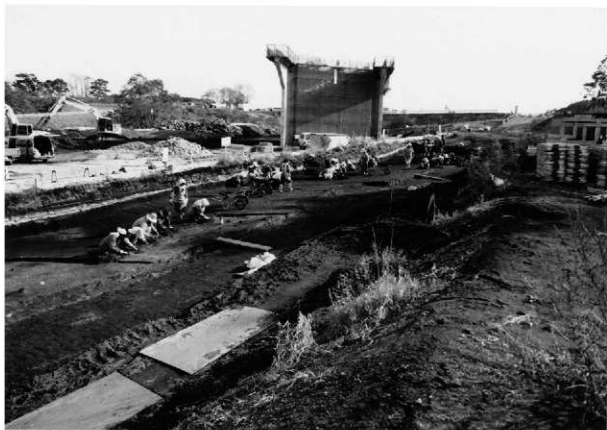
1. 町道部分調査風景（西から）
