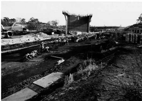
1. 町道部分調査風景（西から）
