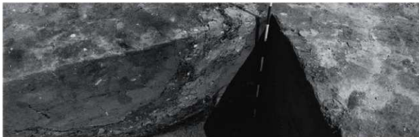
煙道メインセクション NW→SE
