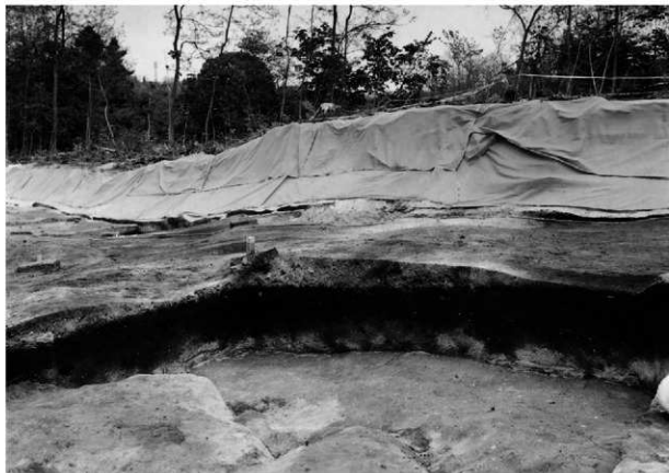
土石流堆積物検出状況(北西側斜面、R-44付近) S→
