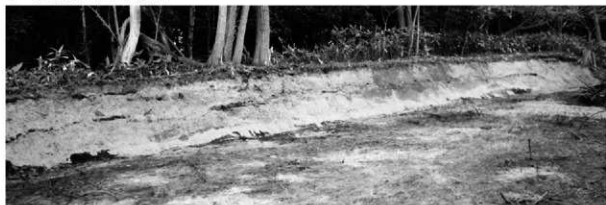
3 茅沼炭鉱鉄道路盤土層断面
