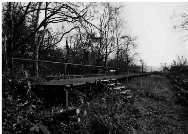
1 岩内線西前田駅プラットホーム跡
