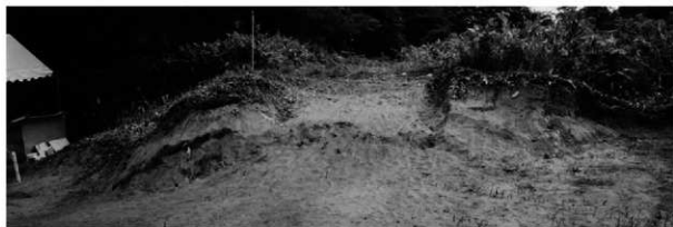
2 岩内線路盤土層断面
