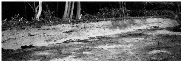
3 茅沼炭鉱鉄道路盤土層断面
