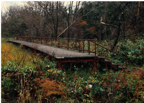
2 岩内線西前田駅プラットホーム跡
