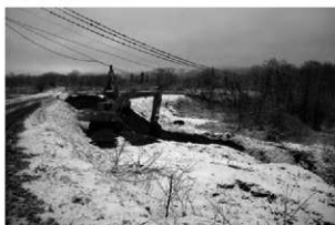
3. 表土除去① (SE→)
