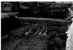
2. 表土除去(南東から)
