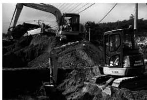
1. 表土除去(南東から)
