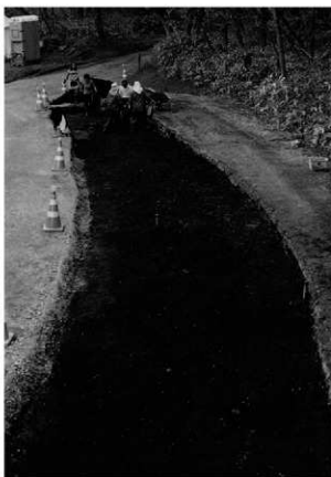
4. 表土等除去後の状況 [北半] (東から)
