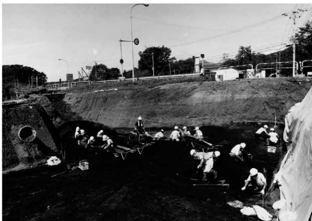
1. 調査状況〔4区〕(南東から)
