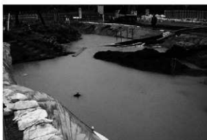
7. 大雨による水害状況(南から)
