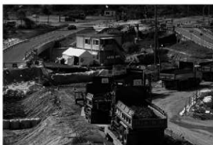
8. 調査区周辺の工事の状況(東から)
