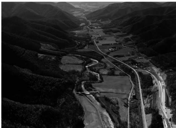
1 旧白滝地区 (北東から、H18撮影)
