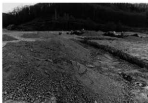
2 B地区 (T~V27区、南東から)
