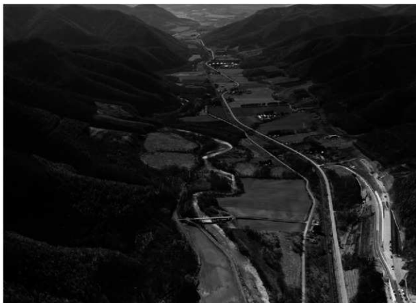
1 旧白滝地区 (北東から、H18撮影)
