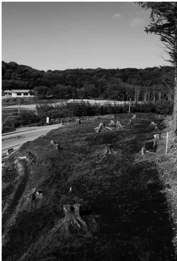
1 調査前状況（南西から）
