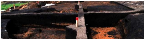
3. III H-7 南北断面 (東から)
