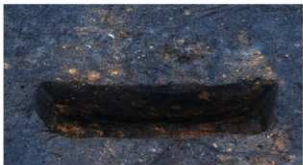
1. III P-26断面 (南東から)
