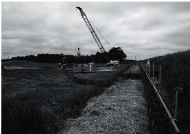
2 鋼矢板打設（平成28年度）
