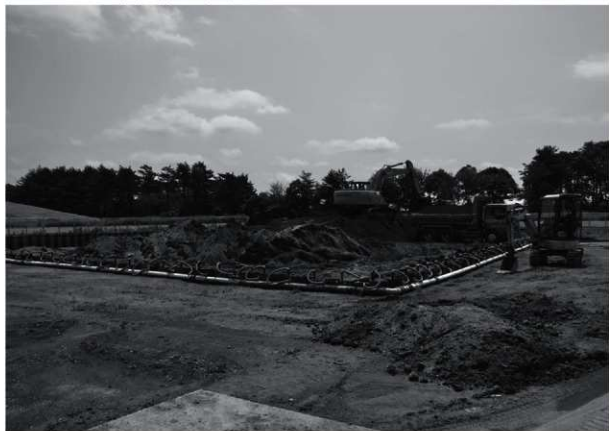
2 表土除去（平成26年度）
