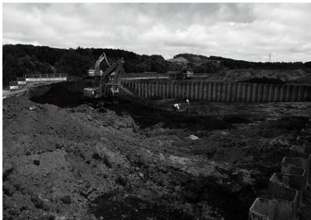
1 表土除去作業(平成26年度)
