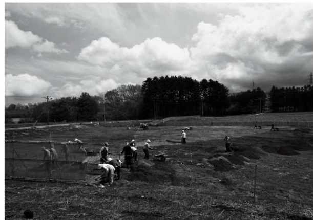
2 調査区南側調査状況
