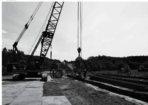
2 鯨矢板打設工事（平成26年度）
