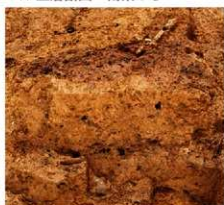
TF-19 土層断面 北東から
