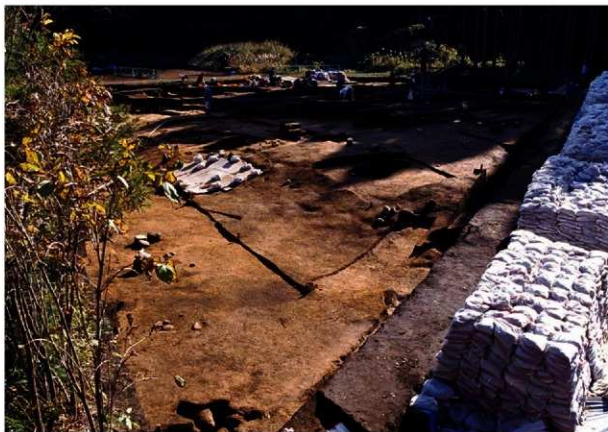
道路側定点観測 平成21年10月28日 北東から
