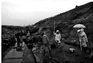
降雨中の測量作業
