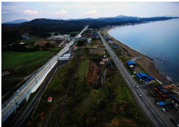
調査区南西から 縦貫するのは左から北海道新幹線・道南いさりび鉄道・国道 228 号
